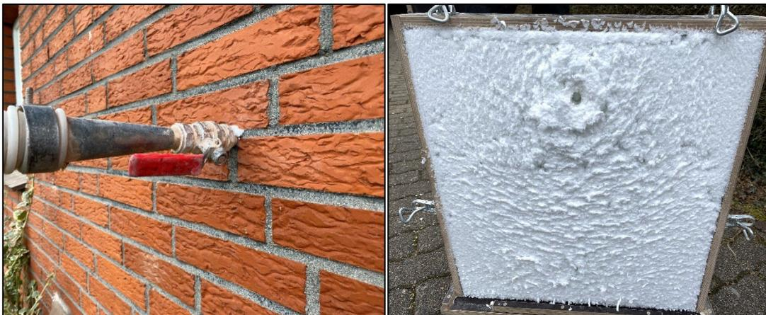
Abbildung 27: Einbringen der Kerndämmung von außen (links), Eingespritztes Dämmmaterial: Mineralfaser der Wärmeleitstufe (WLS) 035 (rechts)
