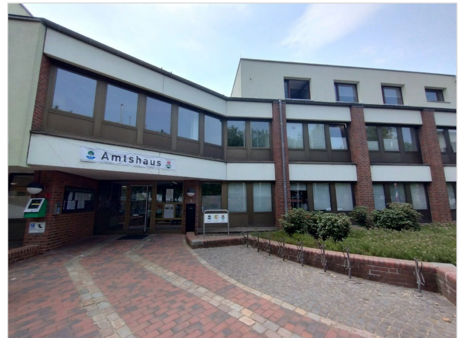
Abbildung 23: Amtsgebäude Trittau (CIMA 2023)
