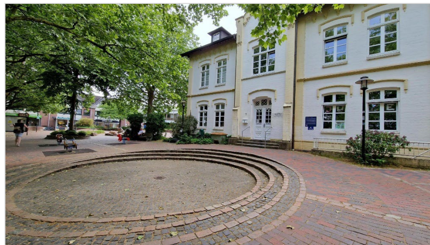
Abbildung 27: Bürgerhaus Trittau (CIMA 2023)
