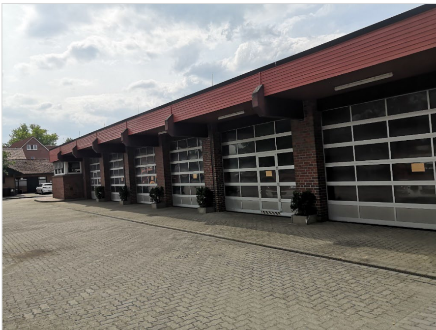
Abbildung 28: Bestehende Feuerwache (CIMA 2023)
