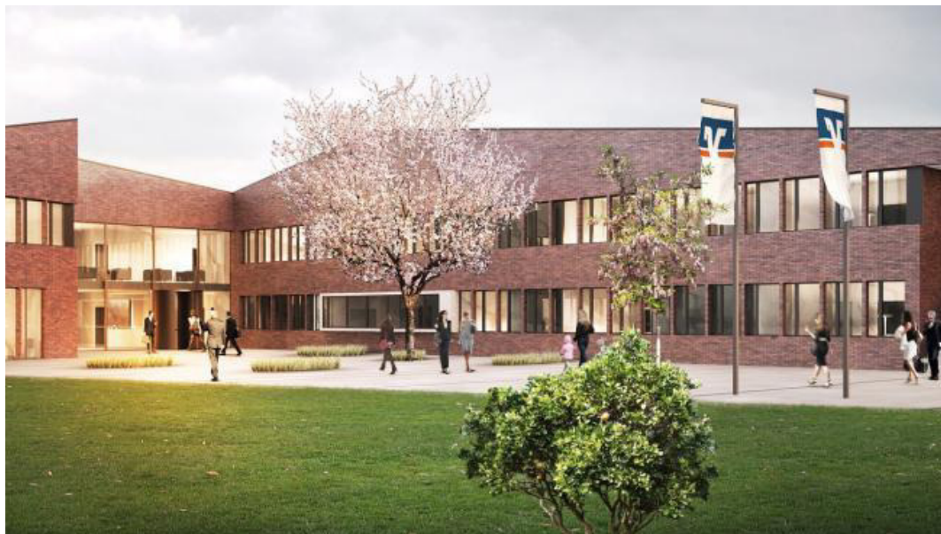
Abbildung 20: Null-Energie-Gebäude der Raiffeisenbank Südstormarn-Mölln e.G.
