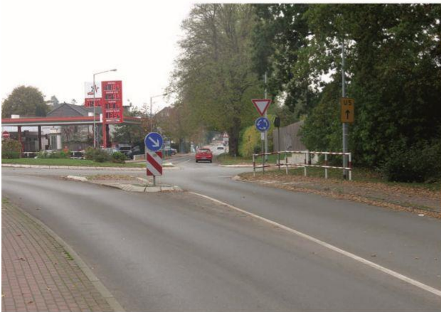
Kreisverkehr L94: Alle Kreisverkehre in Trittau sind wenig rad- und fußverkehrsfreundlich gestaltet. Dies gilt vor allem für die Überquerungsmöglichkeiten und die Anschluss-Radführungen.
