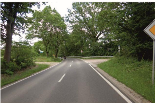
Ortseingang an der K32: An den meisten Ortseinfahrten Trittaus fehlen gesicherte Führungswegwechsel für den Radverkehr, an der K32 liegt zudem eine gefährliche und ungesicherte Überquerungsstelle an der Einmündung Waldstraße.
