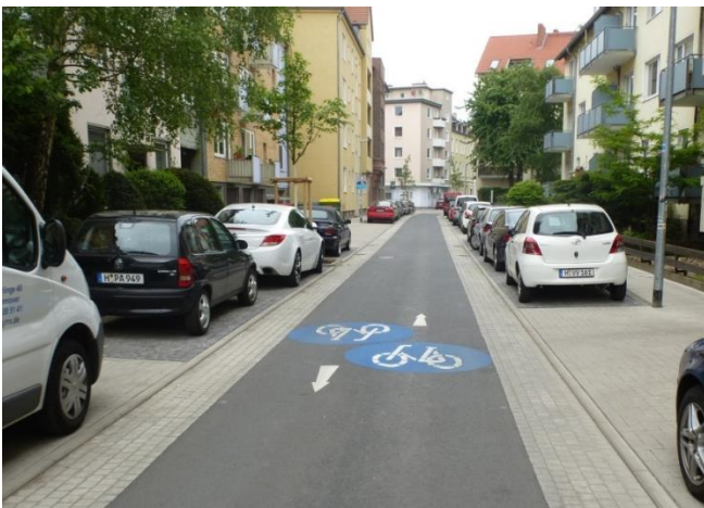
Bild 17: Baulich gestaltete Einbahn- und Fahrradstraße in Hannover
