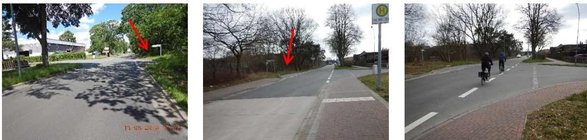
Bild 39 Knotenpunkt Kieler Str. (K 32) / Otto-Hahn-Str. mit fehlendem Führungswechsel, Kennzeichnung einer möglichen Wartefläche für Radfahrende (Pfeil)
