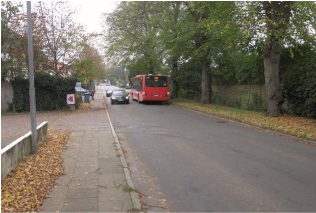
Hamburger Straße: Typisches Bild einer Hauptverkehrsstraße in Trittau mit ausgeprägten Konfliktpotenzialen sowie fehlenden oder nicht regelkonformen Anlagen für den Fuß- und Radverkehr.
