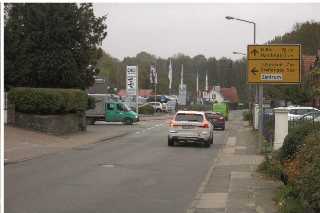
Knoten L94 / L93: Wie fast alle Knoten in Trittau ohne LSA-Sicherung und Kennzeichnung der Radführung - für den Radverkehr unsicher und unkomfortabel zu befahren.
